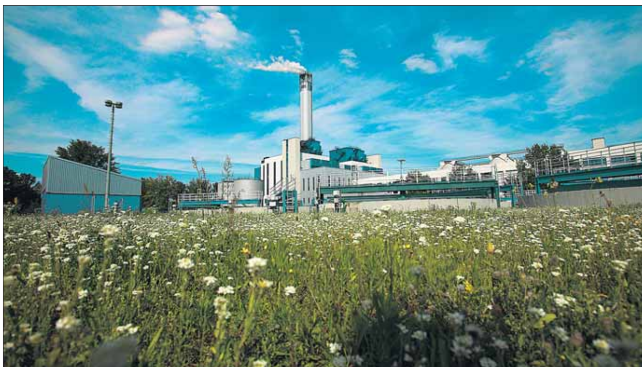
Umweltschutz ist den Berliner Wasserbetrieben eine Verpflichtung. So gelangen aus den Klärwerken (im Bild: Ruhleben) heute schon 82 Prozent weniger Phosphor und 99,5 Prozent weniger Ammoniumstickstoff in Spree und Havel als noch im Jahr 1990
