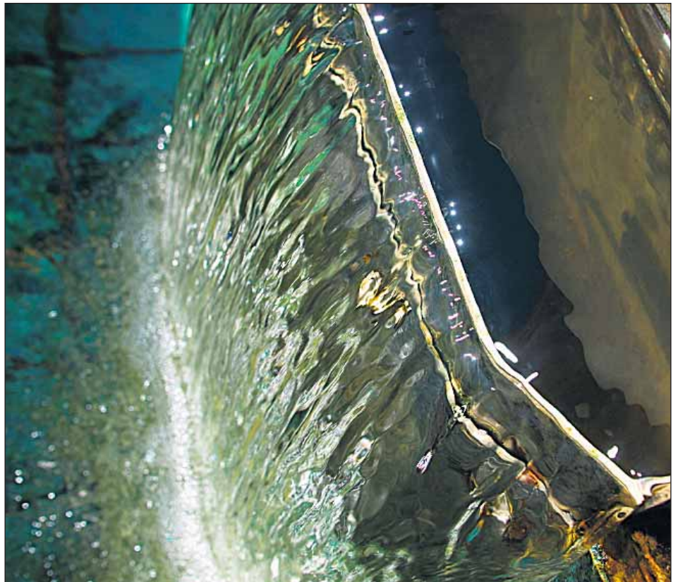
Klar ist steigerbar: So sauber fließt heute gereinigtes Abwasser in die Natur zurück. Im Klärwerk Münchehofe testen die Wasserbetriebe eine noch weitergehende Reinigungsstufe: Mikrofiltration
