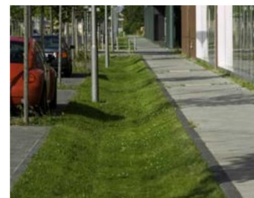
In einem Mulden-Rigolen-System kann Regenwasser versickern und wird auf natürliche Weise gereinigt.
