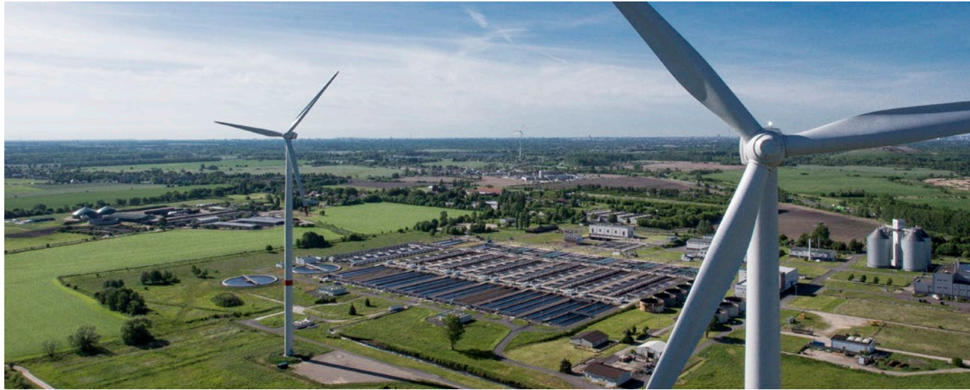
E-MetO pilotiert die Erzeugung von Wasserstoff und Umwandlung zu Methan mittels Power-to-Gas-Technologien im Klärwerk Schönerlinde
