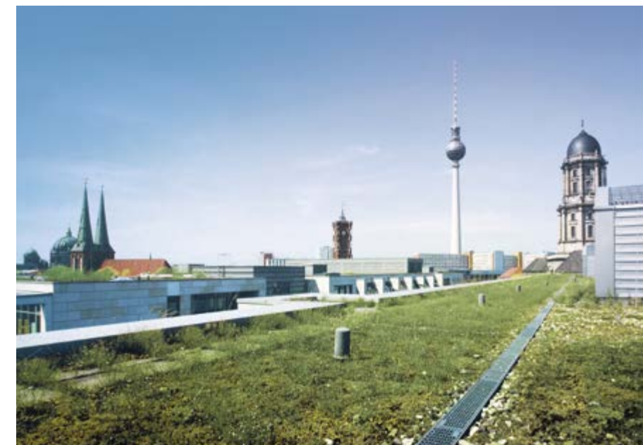
Begrünte Dächer entlasten die Kanalnetze bei Regen und verbessern das Stadtklima.
