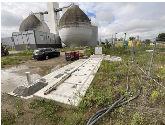
Bild 8 KVA, Spülschacht 4: Ansicht Bauwerk (Quelle: GRBV) Rinsing shaft SP4: view of the construction
