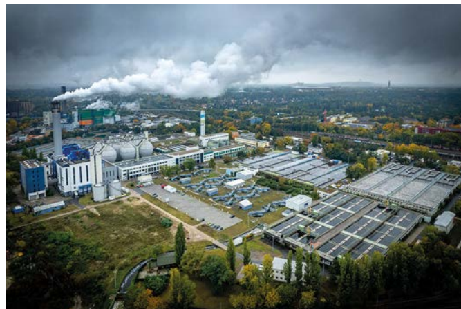
Bild 1 Luftbildaufnahme Klärwerk Ruhleben (Quelle: Berliner Wasserbetriebe) Aerial view Ruhrleben wastewater treatment plant
