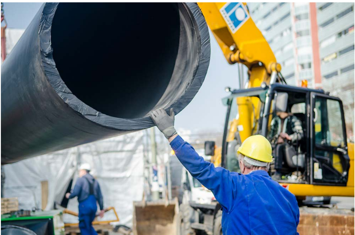
Neuer Kunststoff verjüngt altes Metall: Inliner für eine Abwasserdruckleitung von einem Meter Durchmesser an der Frankfurter Allee.
