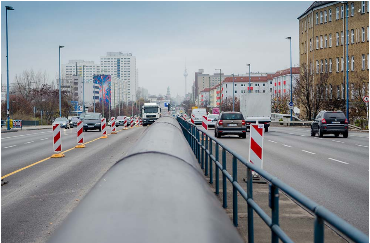
Hunderte Meter Erneuerung am Stück: Inliner auf der Lichtenberger Brücke bereit zum Einzug in eine Abwasserdruckleitung von einem Meter Durchmesser.
