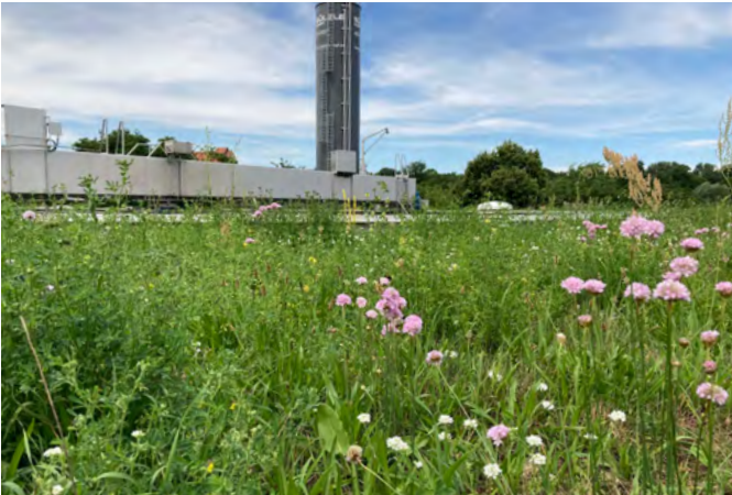
Abb. 23: Oberflächenwasseraufbereitungsanlage Tegel, Dachbegrünung
