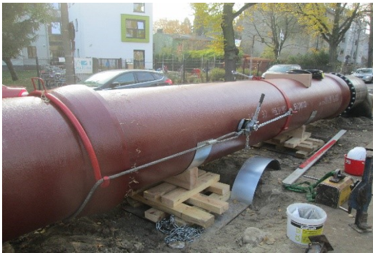
Bild 1 – Montage mit Verlegegerät
