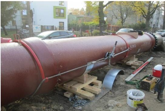
**Bild 1 – Montage mit Verlegegerät**
