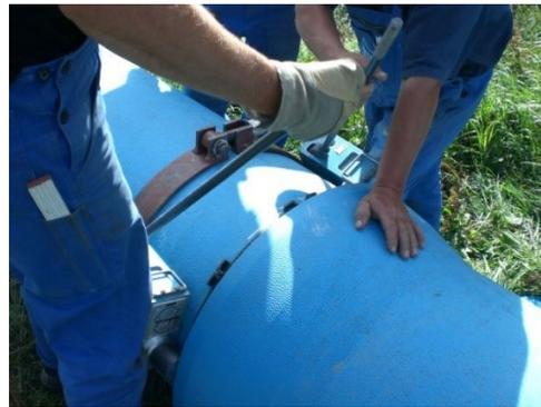
**Bild 2 – Verriegeln mit Hydraulikzylinder**
