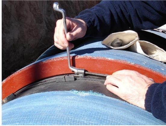
**Bild 3 – Fixierung der Verriegelungssegmente mit verschraubter Spannschelle**
