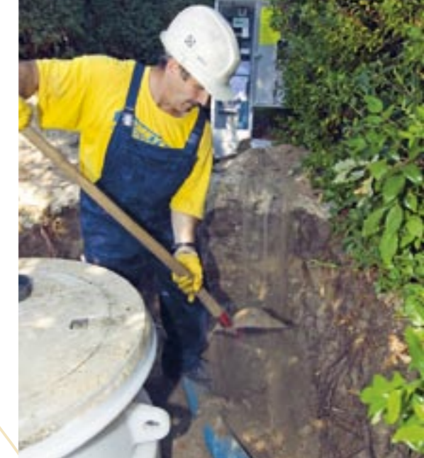
Druckentwässerungsanlage, Einbaueimer
